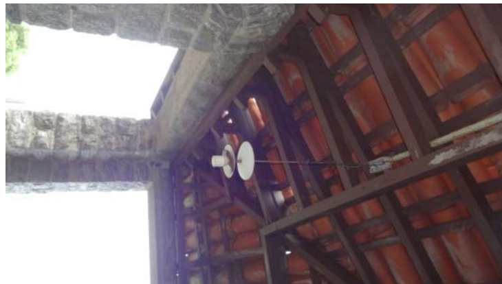
Fig. 6: Eletroduto em claros sinais de corrosão.
