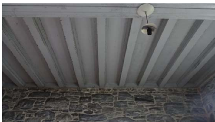
Fig. 4: Iluminação passando por dentro do barroteamento.
