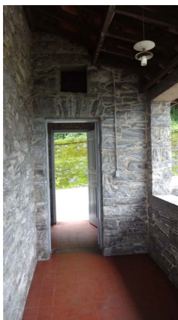
Fig. 3: Instalação aparente de iluminação.
